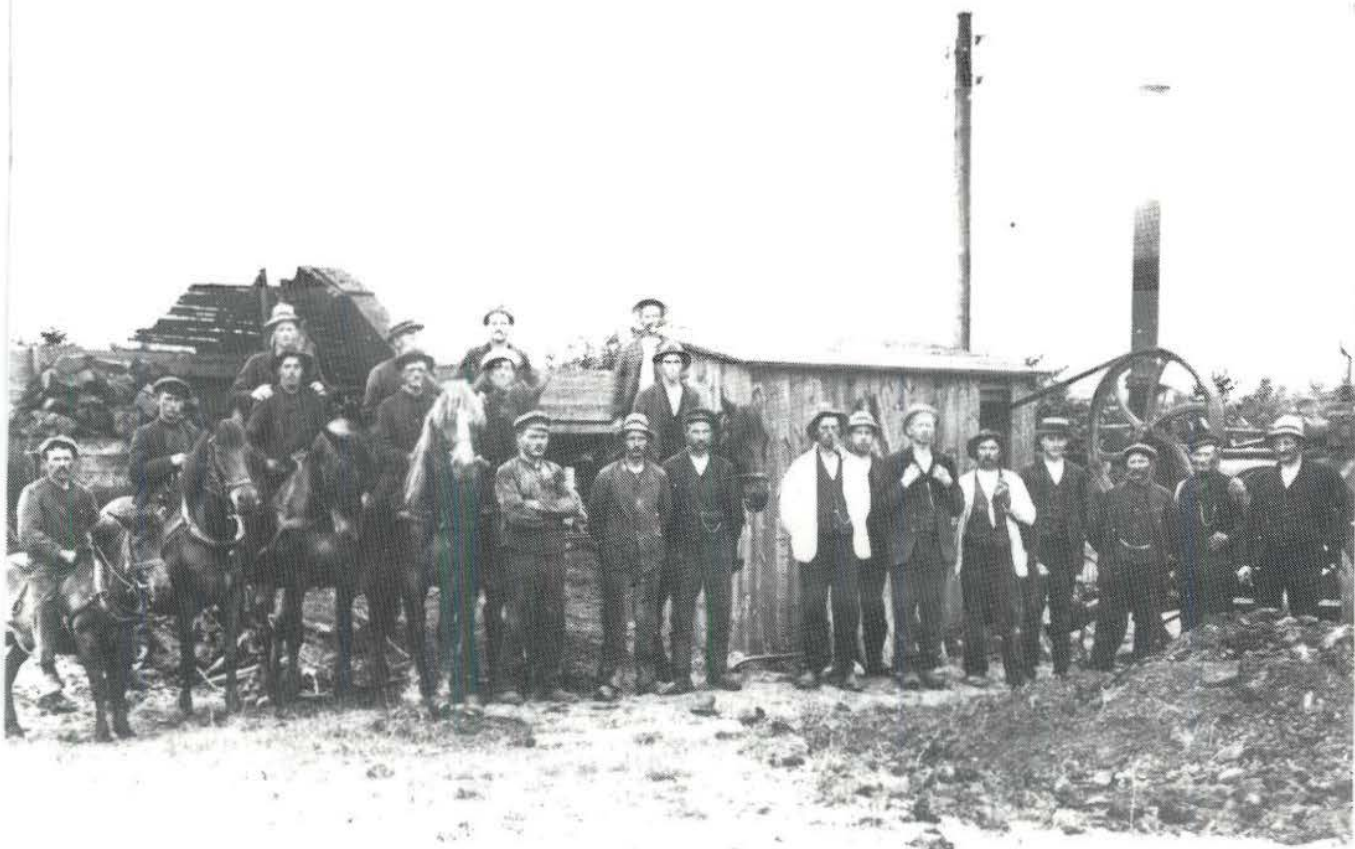
Et andet ælteværk, hvor personerne også er ukendte. Værket drives af et lokomobil; men der er tilsyneladende også indlagt el.
